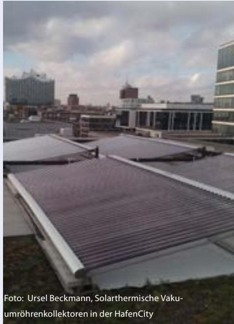
Foto: Ursel Beckmann, Solarthermische Vakuumröhrenkollektoren in der HafenCity
