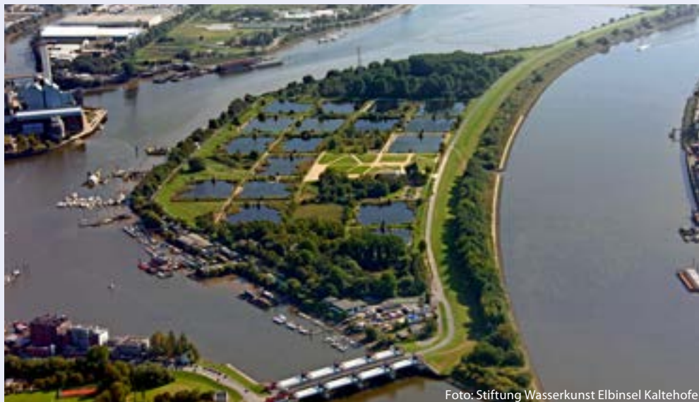
Foto: Stiftung Wasserkunst Elbinsel Kaltehofe
